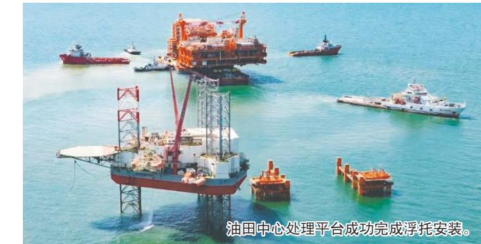
油田中心处理平台成功完成浮托安装。
