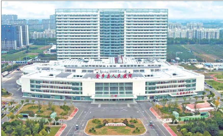
金乡县人民医院新院区。
