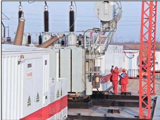
变电站运维人员使用红外测温仪对主变压器进行测温。 通讯员 孙绍华 摄
