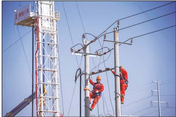
输电运维人员登杆进行高压开关安装作业。 通讯员 孙绍华 摄
