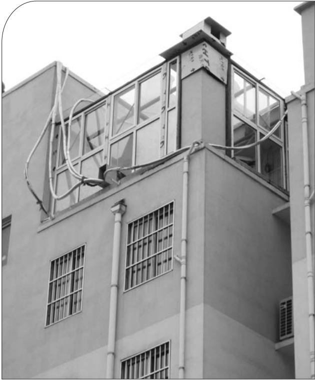
二单元顶层西户搭建了玻璃房。
