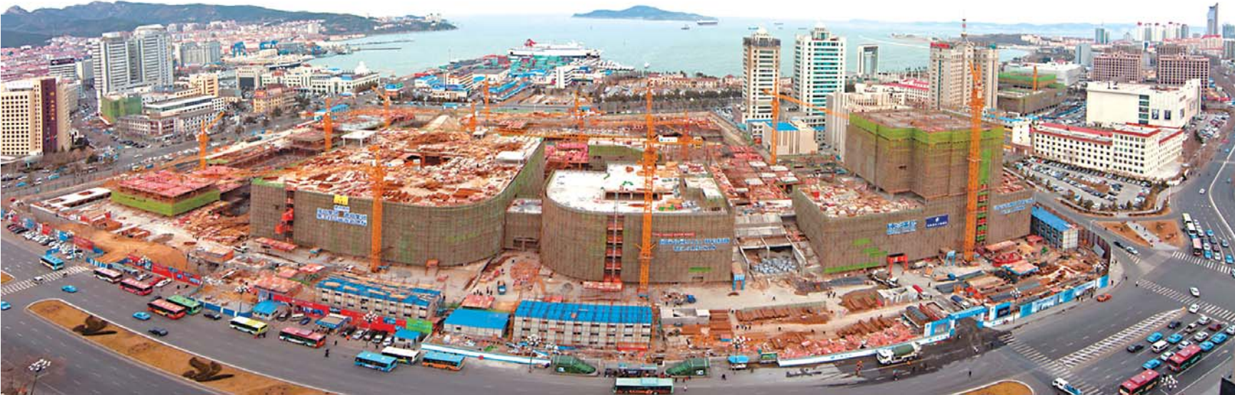
正在施工的威高广场。
