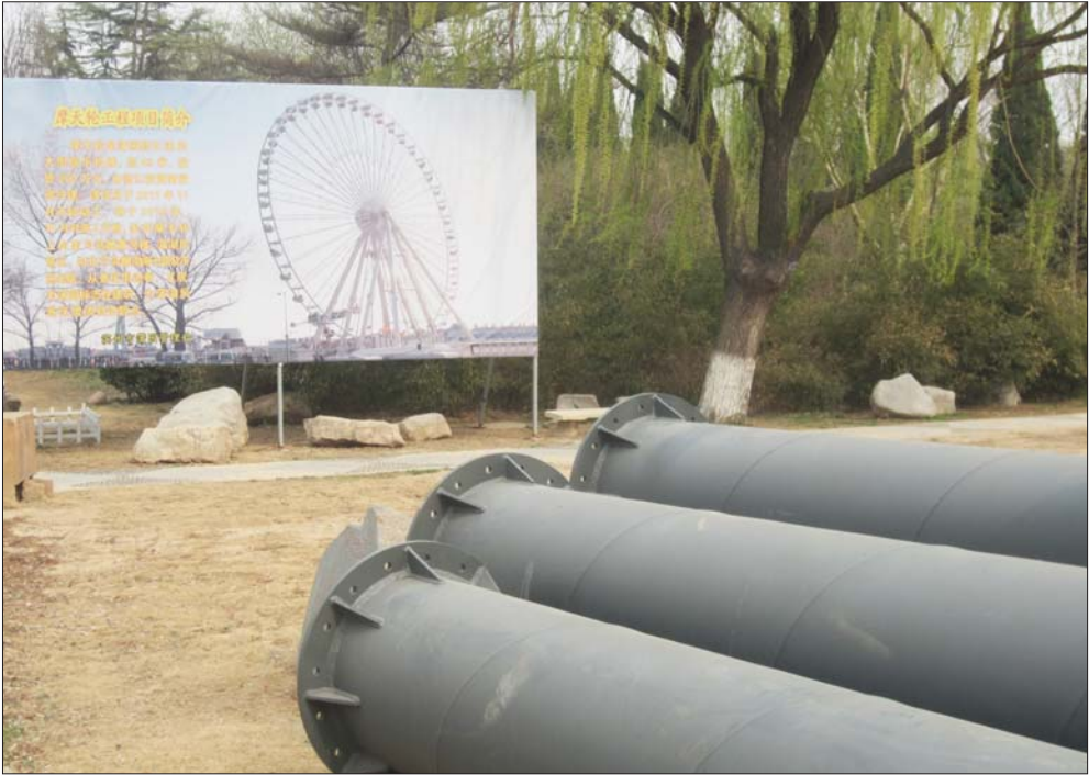
摩天轮建设工地。 记者 张卫建 摄
