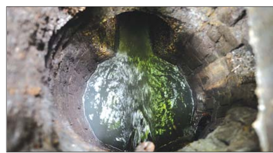
槐荫老商埠区的百年地下排水管道,至今仍畅通无阻。本报记者 王媛 摄
