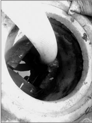
水泵抽水,解不了排水难题。 本报记者 牟张涛 摄
