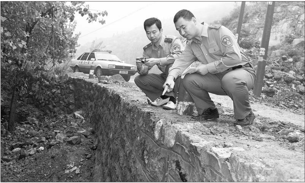
排查隐患 根据雨季道路交通隐患多发的特点,淄川区交通部门加大力量,对辖区内道路进行排查抢修。截止目前,工作人员共排查农村道路2000余公里,消除安全隐患2处,抢修水毁路段11处。图为淄川区交通运输局路政管理人员排查山区道路水毁隐患。 本报通讯员 高荣长 张悦 摄影报道
