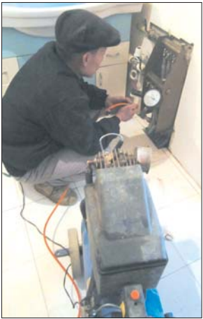
维修工正在检测暖气是否漏水。 记者 曲彦霖 摄
