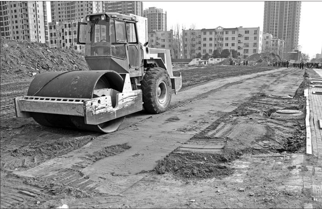
压路机正在作业。本报记者 李岩松 摄
