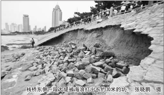
栈桥东侧一段大堤被海浪打出长约30米的坑。 张晓鹏 摄
