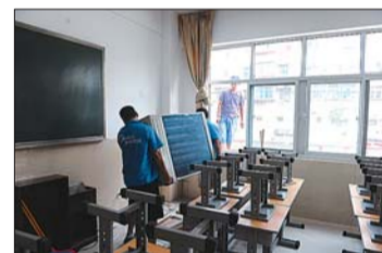
28日，在汇波小学，施工人员正在为教室装空调。 本报记者 李飞 摄
