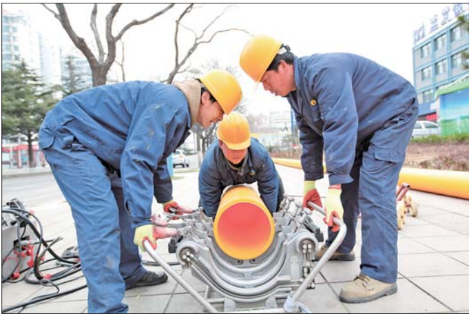
▲青岛路附近,威海港华燃气有限公司工作人员正在进行铸铁管改造。(资料片)
