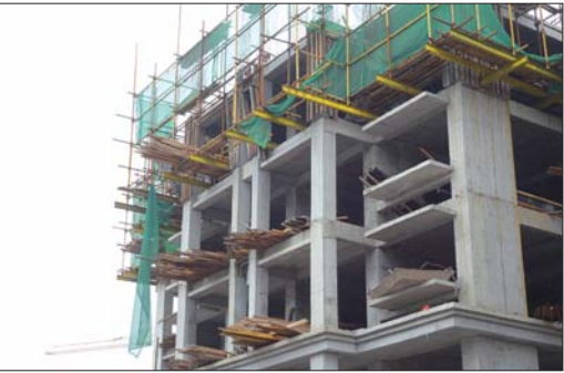
“状元府”住宅楼工程
