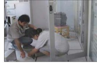
由于部分变电站直流设备老化，存在安全隐患，9月2日至6日，国网沂源县供电公司对35千伏金星变电站等部分变电站站内直流充电模块及蓄电池进行了更换。
