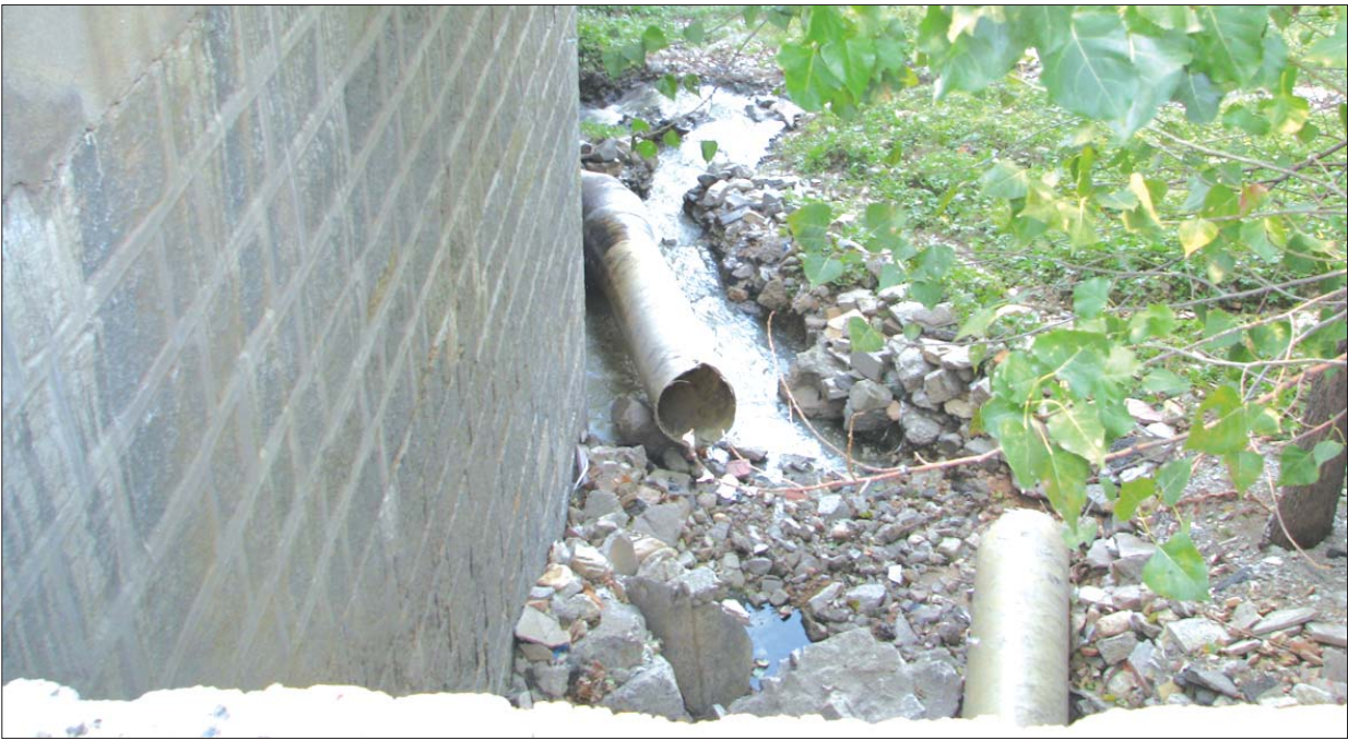
断掉的污水管道大约十多米。
