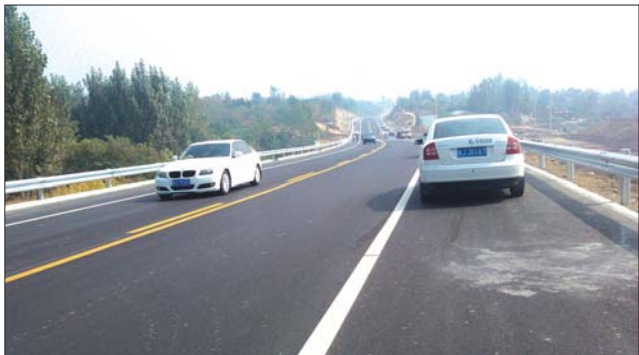
环山路东延工程顺利通过验收。本报记者 王世腾 摄
