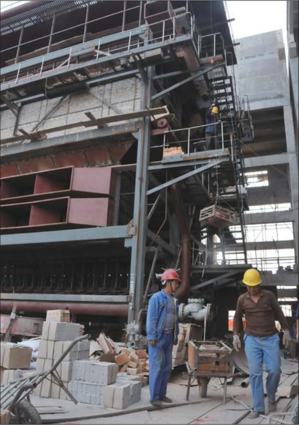
位于鑫谊热电厂的新建热水锅炉正在进行筑炉工程建设。 本报记者 杨青 摄
