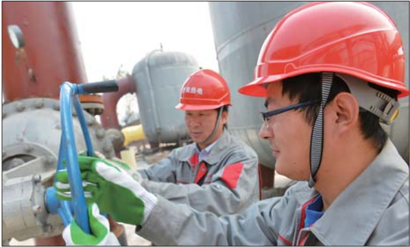
北郊热电厂工作人员打开阀门,对纬二路新铺设的供热管道打压试水。本报记者 蒋龙龙 摄
