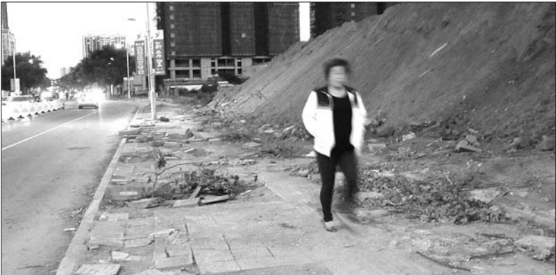
▲威海路部分路段因为施工,人行道盲道暂时不能使用。 本报记者 李玉涛 摄
