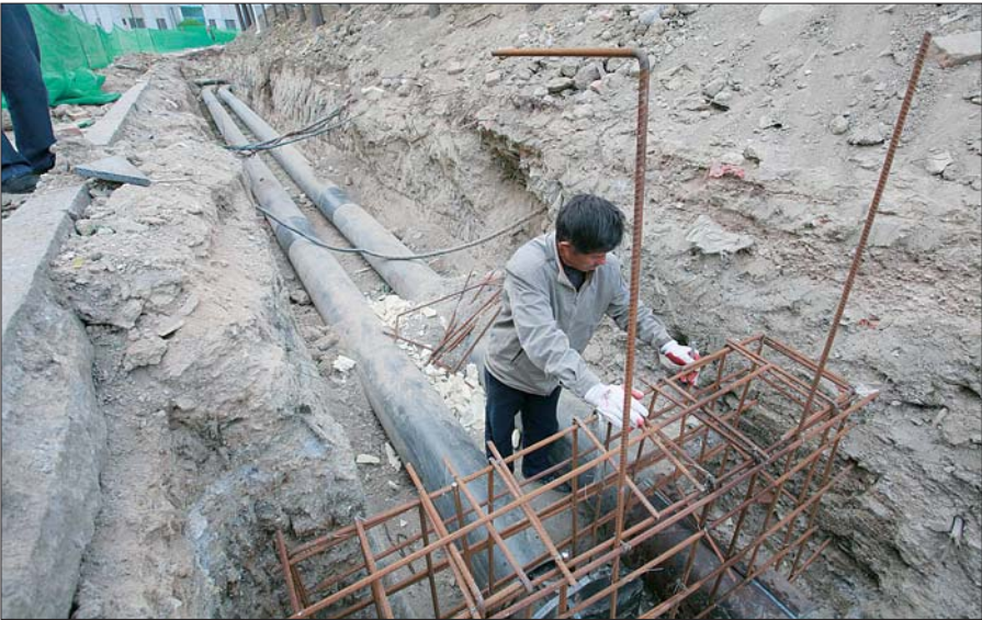
20日下午,工作人员对城建花园内部的供热管网进行维修改造。 本报记者 刘涛 摄
