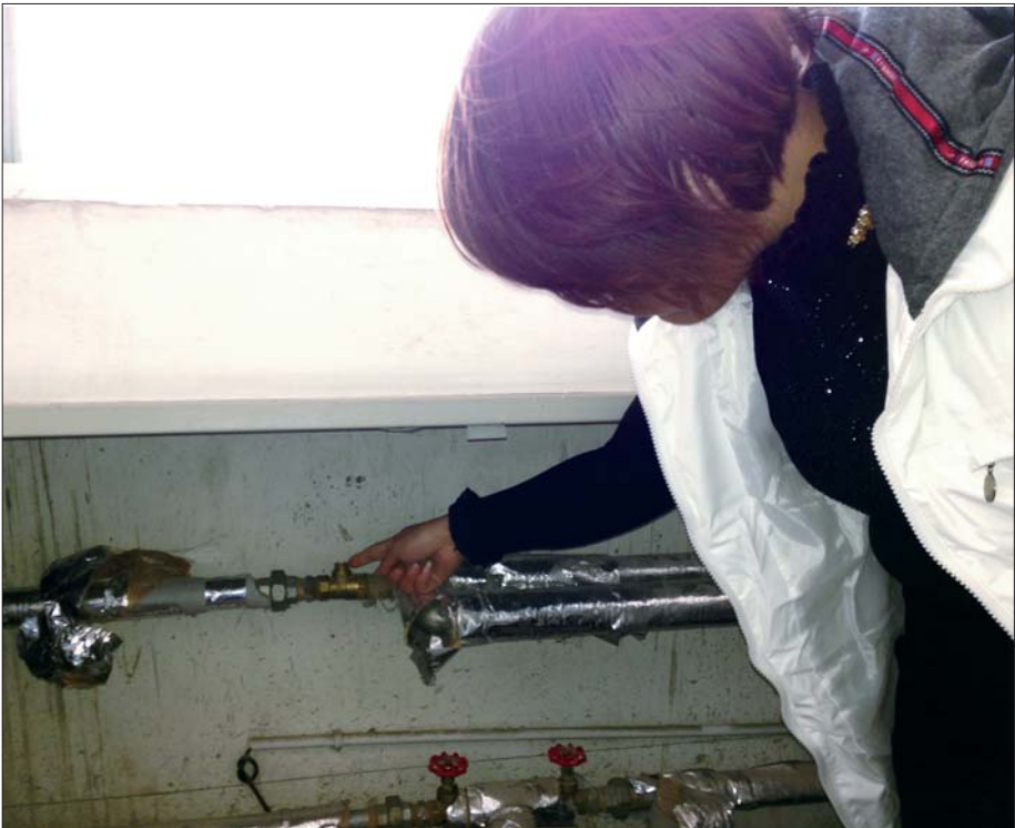
阀门发生破损。张林 摄
