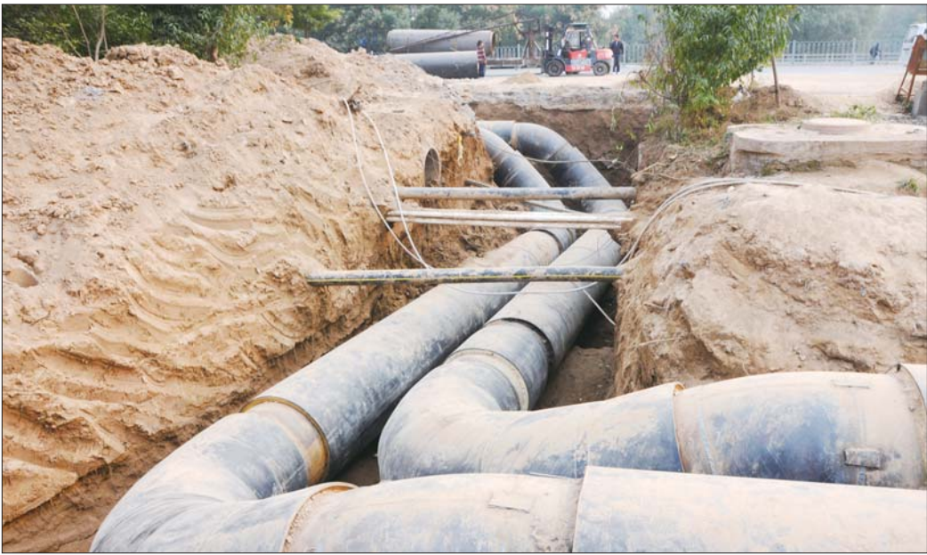
10月28日,在天衢路一供暖管道铺设现场,地下管道已经焊接完毕。 本报记者 马志勇 摄
