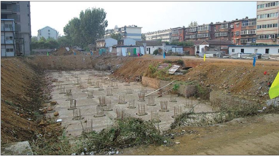
槐苑欣城1号楼周边杂草已经清理完毕,复工在即。 本报记者 陈伟 摄
