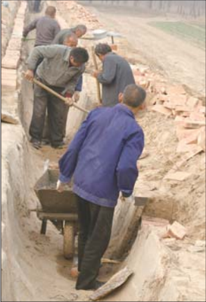
水渠施工现场。本报记者 张建新 摄
