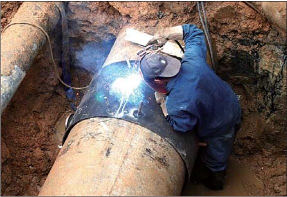
工作人员焊接破损管道。 本报通讯员 孟华 摄
