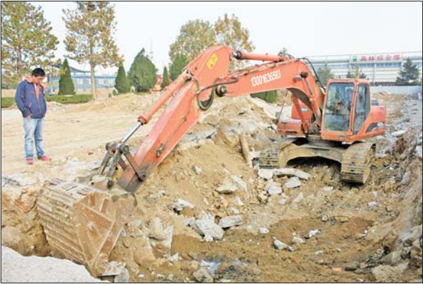
▲乒羽健身中心施工现场。 记者 王帅 摄
