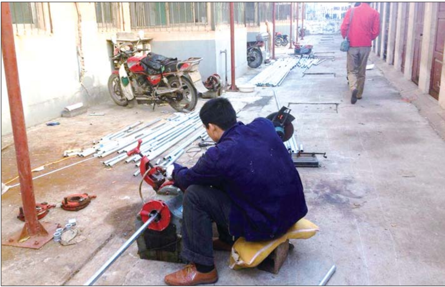
一位工人正在对暖气管道进行切割。
