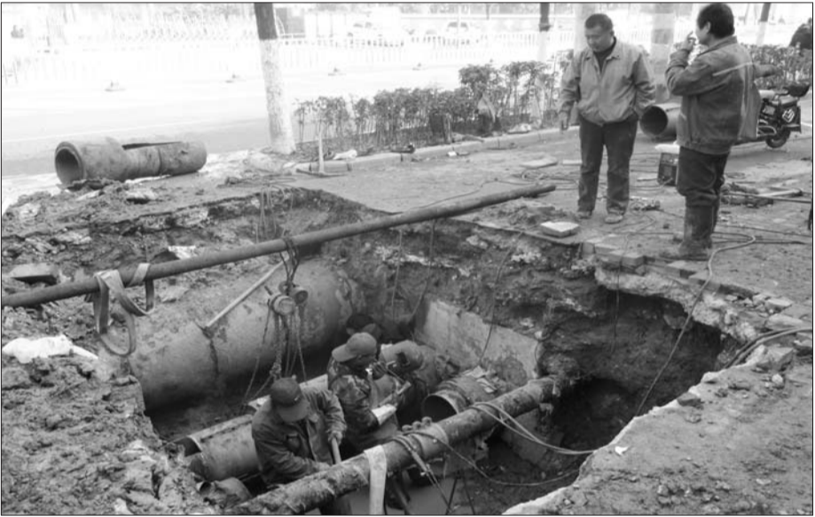
检修工人正在抢修破裂管道。 本报记者 韩微 摄
