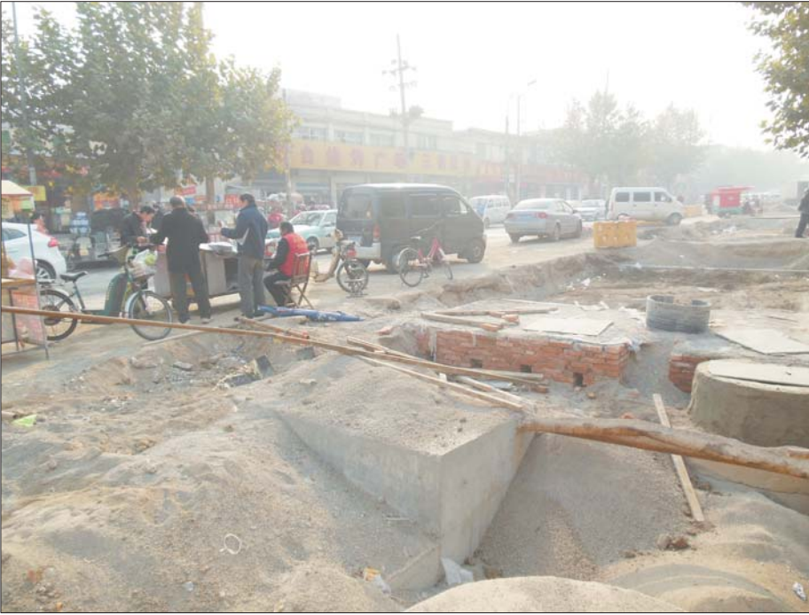
半月前已经施工完毕,化纤厂路还没有回填。
