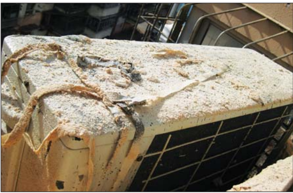
外墙粉刷完毕后,居民楼外的空调机上都是油漆。 实习生 闫卫巧 摄
