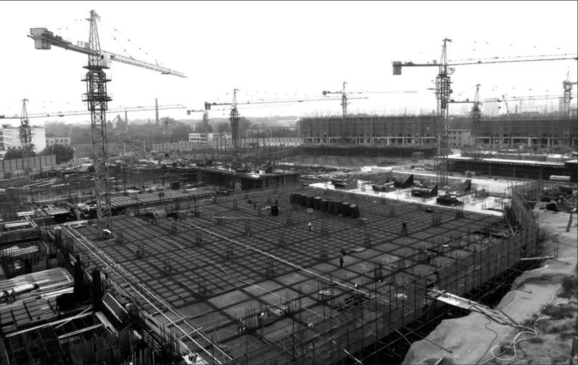
钢城某大型项目现场,工人正在施工。 记者 程凌润 摄
