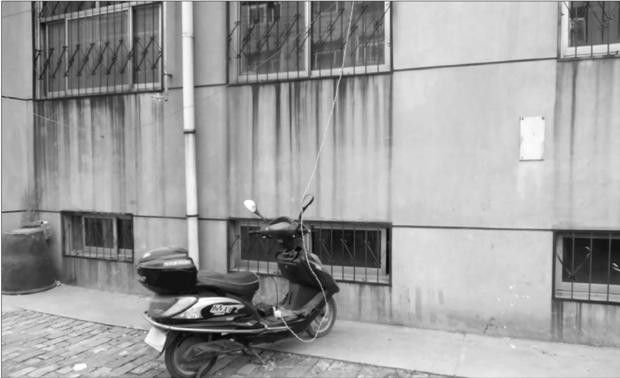
一些老小区,电动车高空拉线充电的现象很普遍。 本报记者 郭庆文 摄
