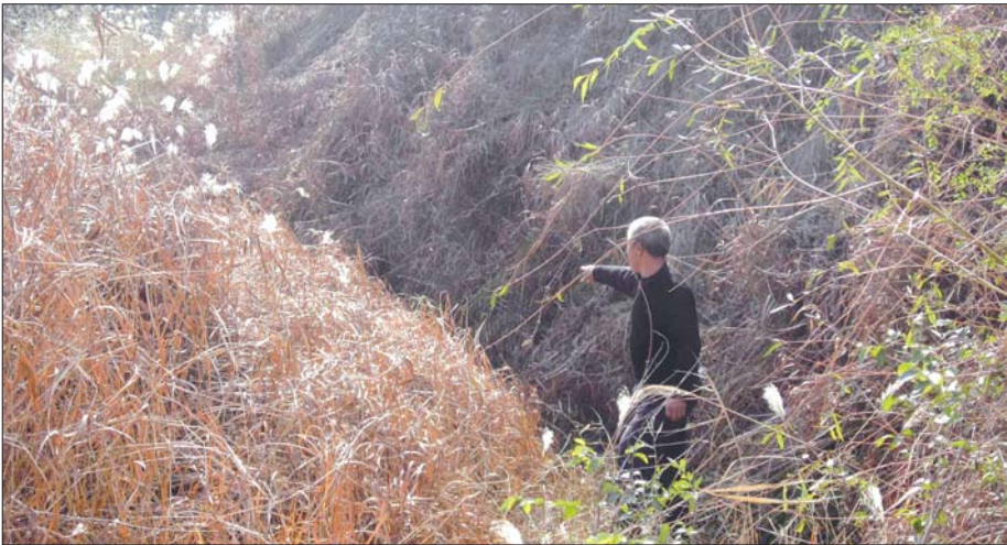
下雨时周围的泥土被冲走,排水沟不断扩大。 本报记者 张姗姗 摄
