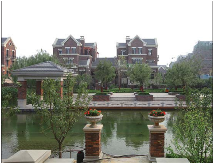
重汽翡翠莱蒙湖工程项目
