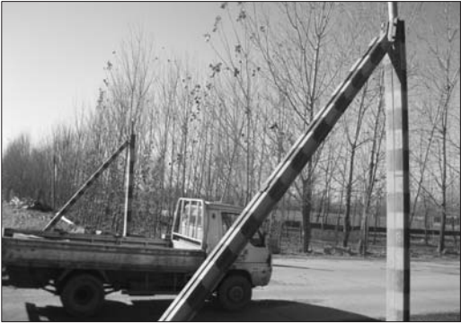
铁路桥北侧被撞坏的防护架。 本报记者 王瑞超 摄
