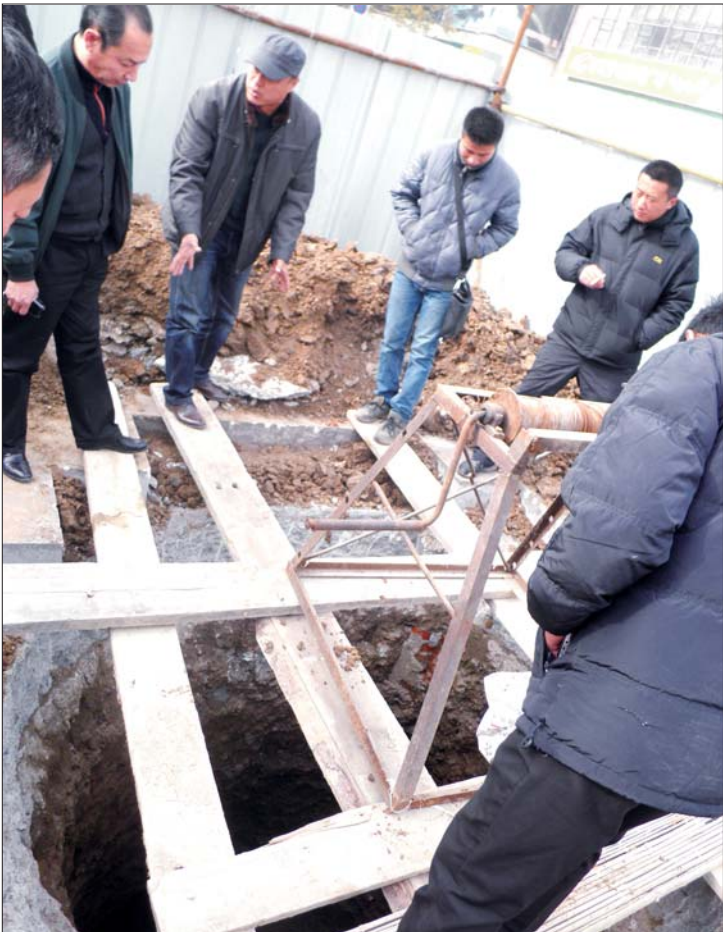
秀水城西南直排口改造现场。
