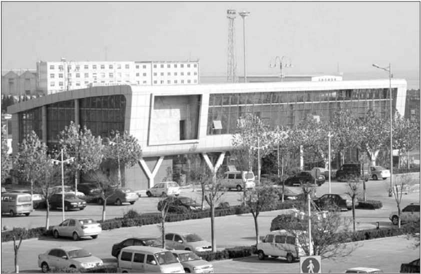
新站房建筑面积2000多平方米,主体已建设完工,正在进行内部装修。 本报记者 李泊静 摄
