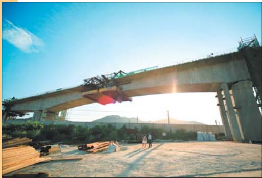
▲青烟直通线跨蓝烟线连续梁对接完成。
