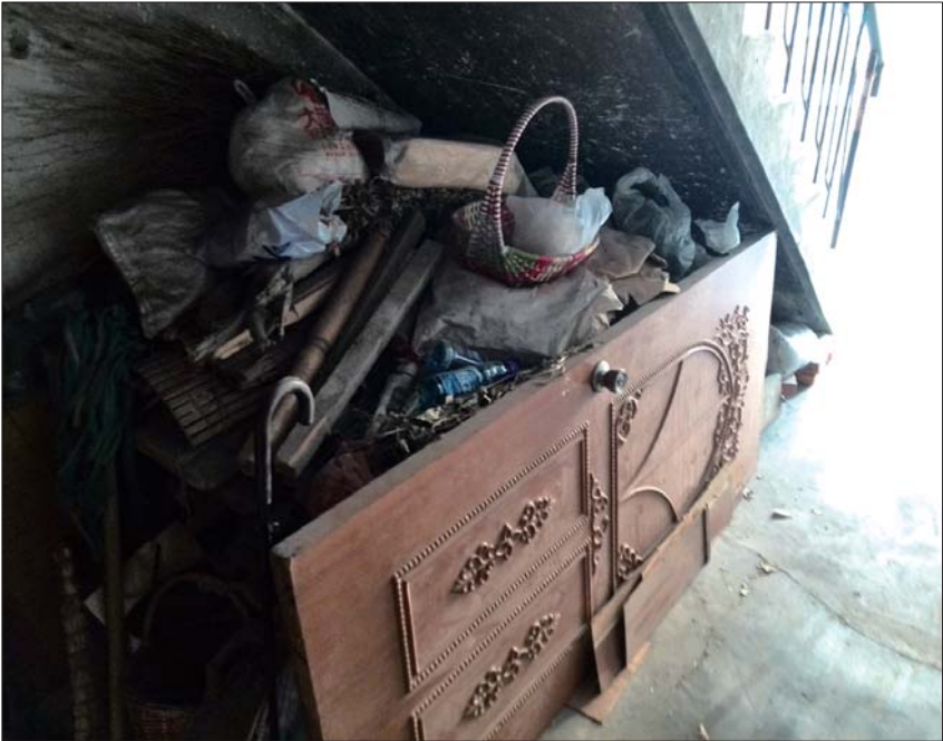
一楼楼梯下堆满了杂物
