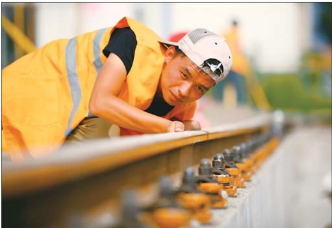
测量员李彪正在检测轨距,对于工程质量他丝毫不敢马虎。
