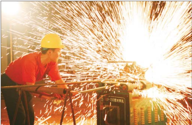
钢筋对焊火花散落,工人忙得热火朝天。
