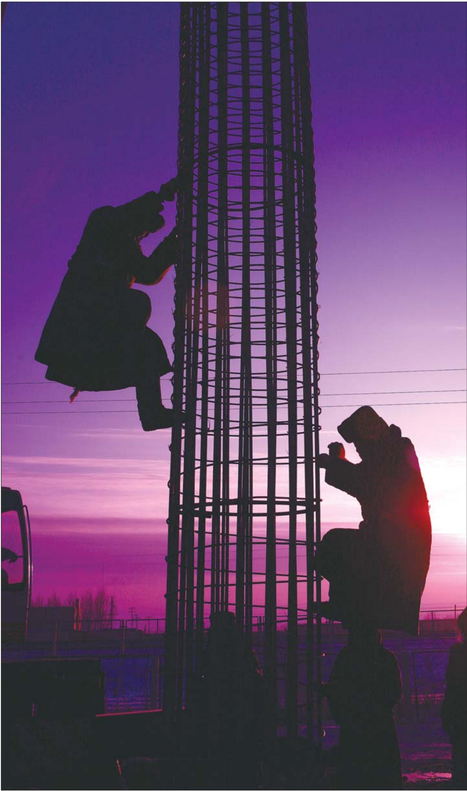
伴着美丽的霞光,2名工人正在吊装桩基钢筋笼。
