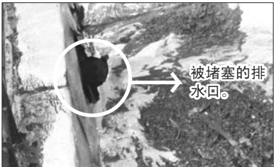
当时被堵的排水口及从中挖出的填堵物。
