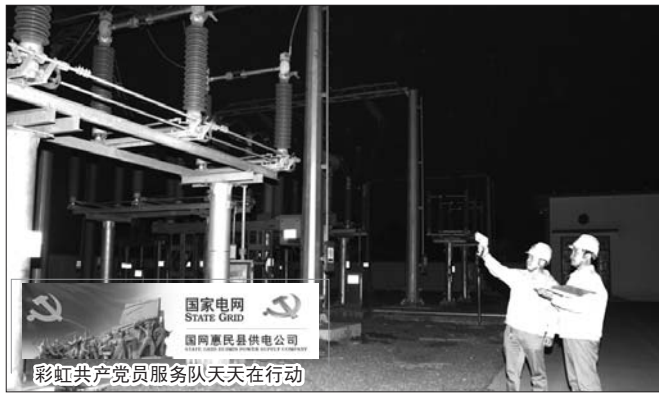
近期大雾及雾霾天气频发,容易引起输变电设备绝缘子受潮,形成放电通道,造成开关保护动作跳闸。为及时掌握输变电设备的运行状况,确保电网安全可靠运行,惠民公司结合输变电设备状态检修工作计划安排,安排专人分别对110千伏变电站及重载线路进行了红外测温监测污闪工作,共检测变电站4座、杆塔42基、128个点位,发现异常4处,均进行了污闪故障消除。图为宫绍青、曹建忠在阎盖变电站进行测温。
