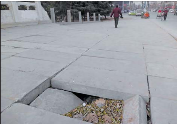
汇金街运河桥上石板断裂后形成的大坑。 本报记者 郭庆文 摄
