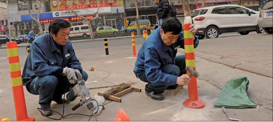
14日,济南汇科旺园小区正在消防通道安装隔离桩。 本报记者 戴伟 摄
