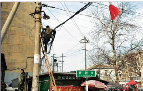
工作人员正在现场维修。 本报记者 张倩倩 摄
