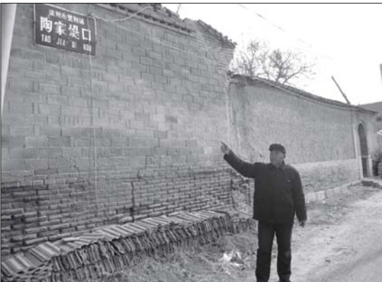
老宅北厢房侧墙。
