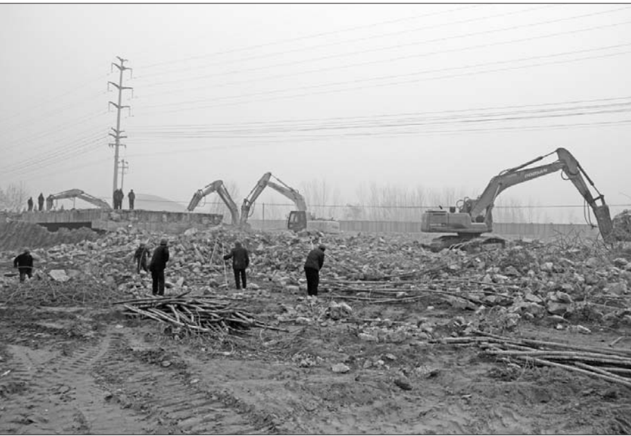
湖南路徒骇河大桥开始拆除。 本报记者 谢晓丽 摄
