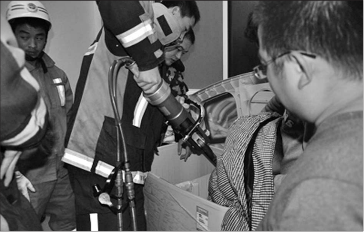
消防官兵对洗衣机进行拆除。本报通讯员 李楠 张超 摄
